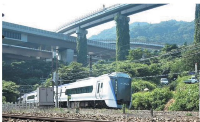
散策記「いのはなトンネル」付近
