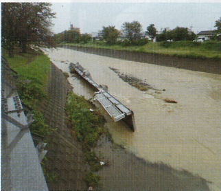
台風19号、南浅川の被害状況
